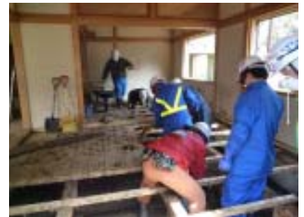
床板をはがしてドコの除去作業
